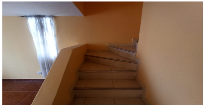
Escalera del inmueble
