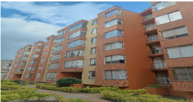
Fachada del Inmueble
