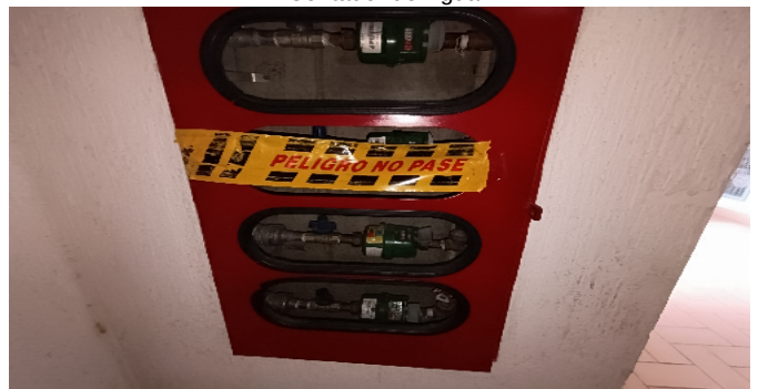
Contador de Agua
