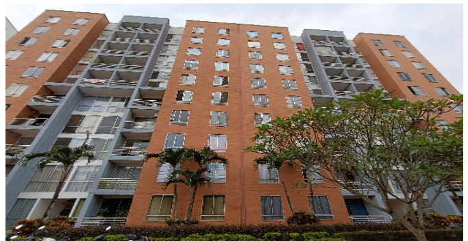
Fachada del Inmueble
