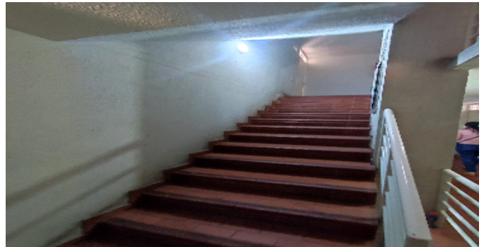
Escalera común - CJ
