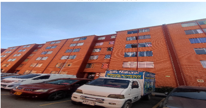
Fachada del Inmueble
