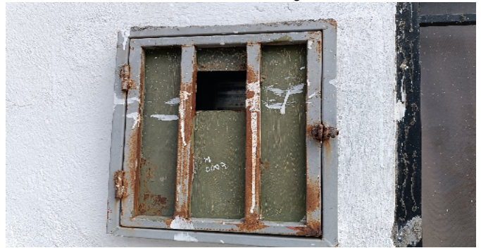
Contador de Energia
