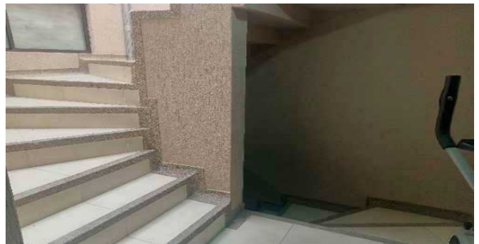
Escalera común - CJ
