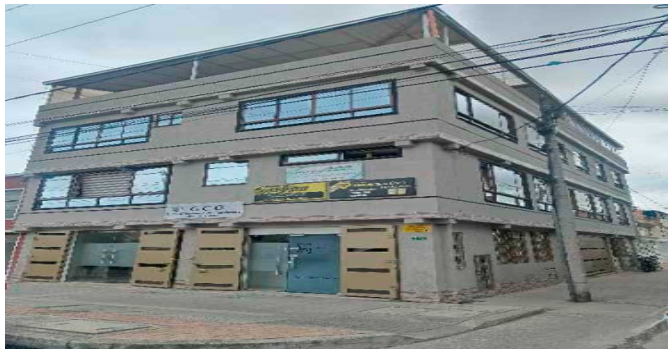
Fachada del Inmueble
