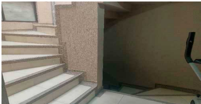
Escalera común - CJ
