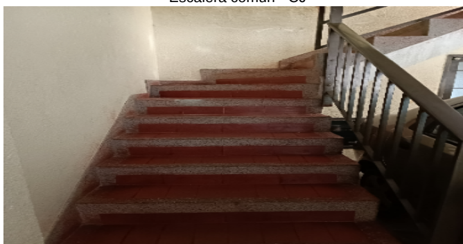
Escalera común - CJ
