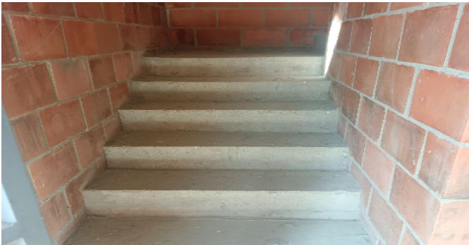
Escalera del inmueble
