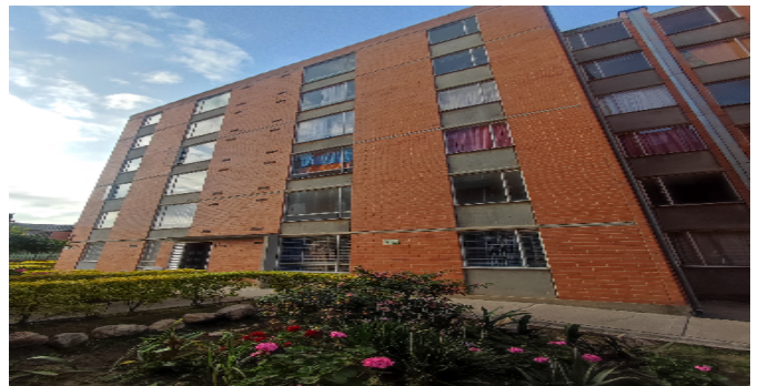
Fachada del Inmueble
