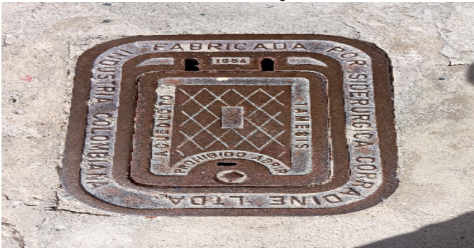
Contador de Agua
