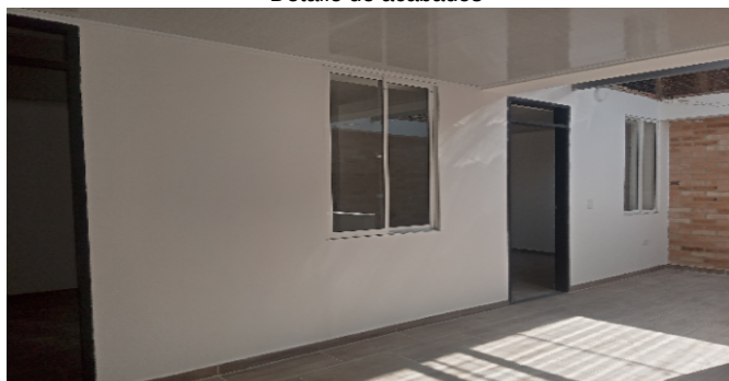
Detalle de acabados
