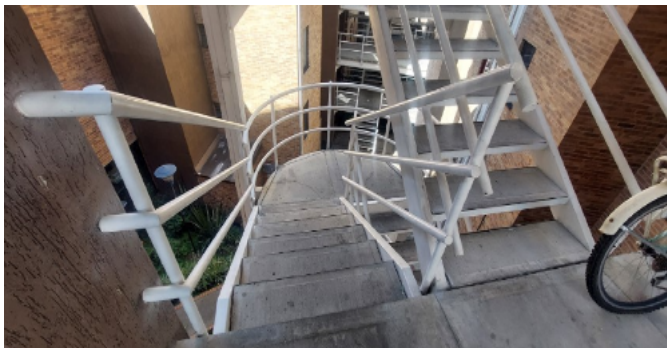
Escalera común - CJ
