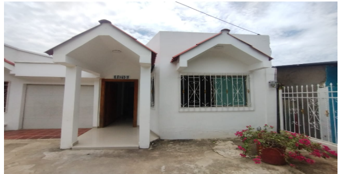
Fachada del Inmueble
