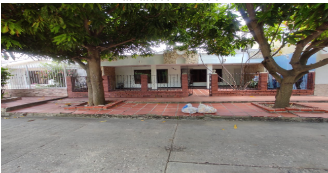
Fachada del Inmueble
