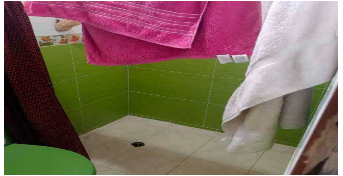
Baño Privado Hab 1
