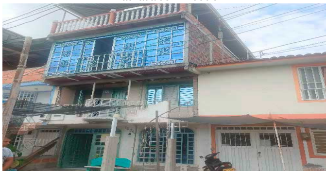
Fachada del Inmueble
