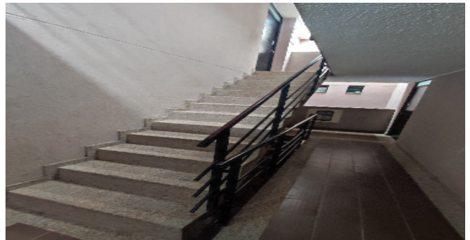
Escalera común - CJ
