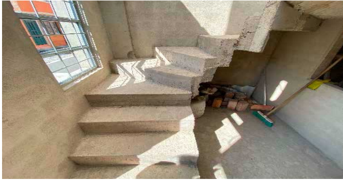
Escalera del inmueble
