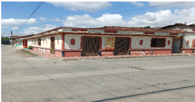
Fachada del Inmueble
