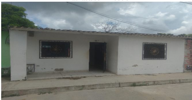
Fachada del Inmueble
