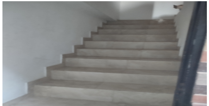
Escalera del inmueble
