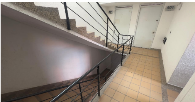
Escalera común - CJ
