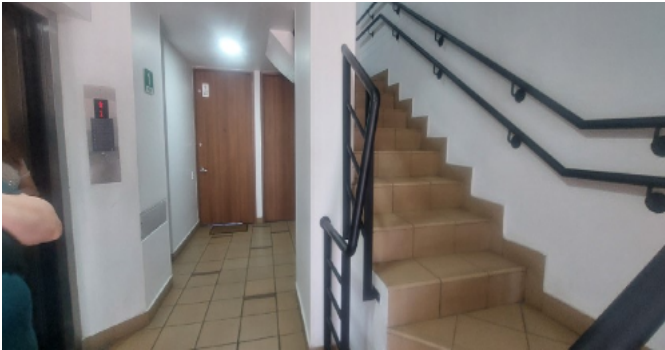
Escalera común - CJ
