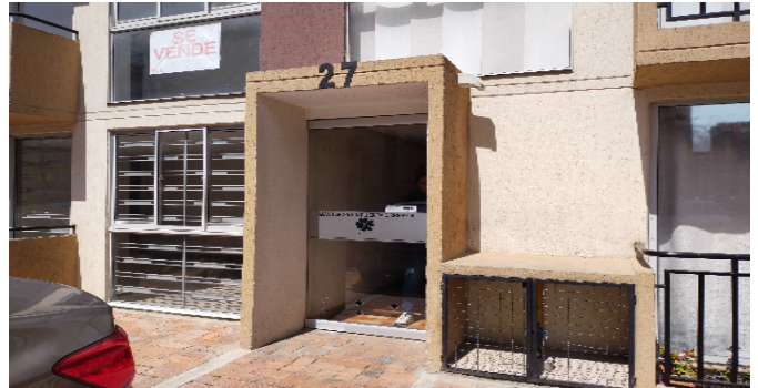
Entrada a la torre
