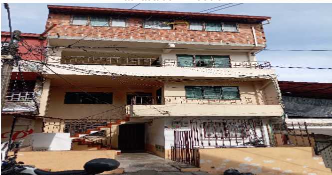
Fachada del Inmueble
