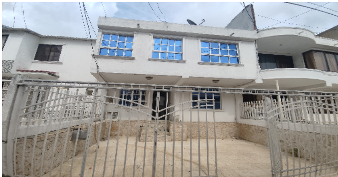
Fachada del Inmueble
