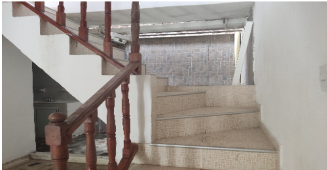
Escalera del inmueble
