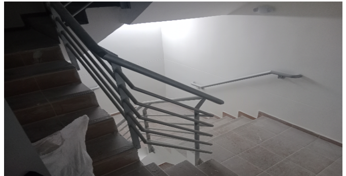
Escalera común - CJ
