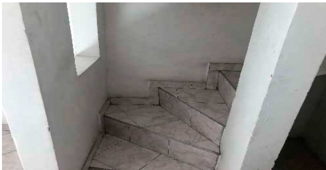
Escalera del inmueble
