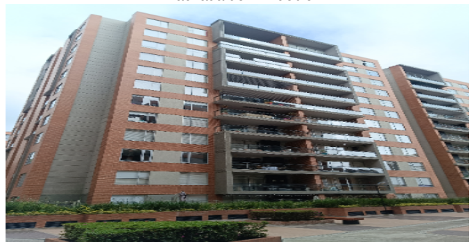
Fachada del Inmueble
