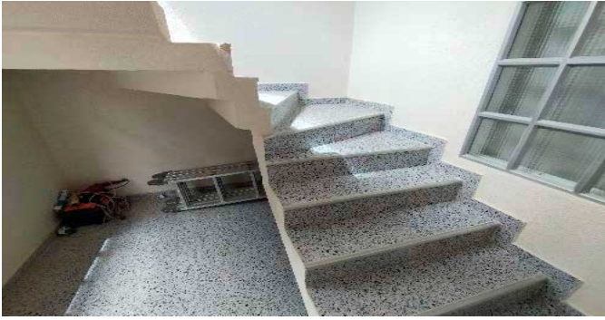
Escalera común - CJ
