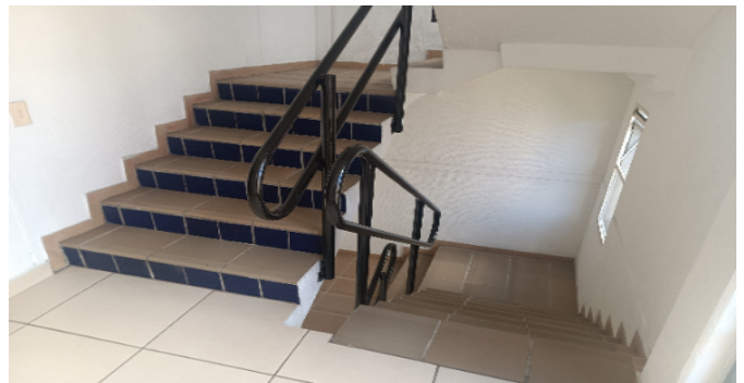
Escalera común - CJ
