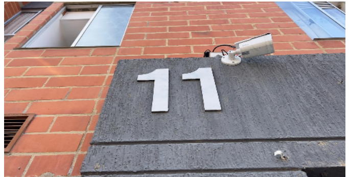
Fachada del Inmueble
