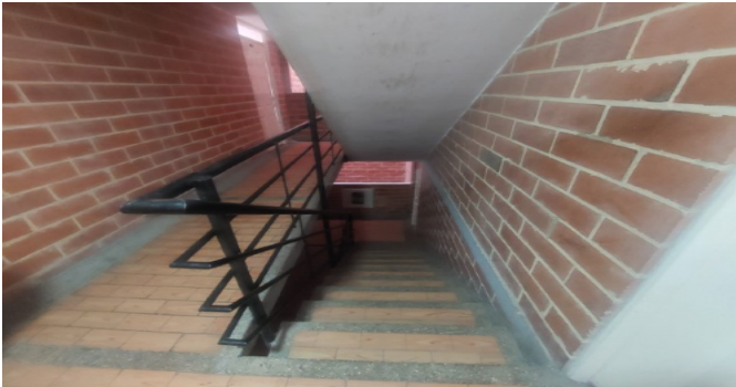
Escalera común - CJ
