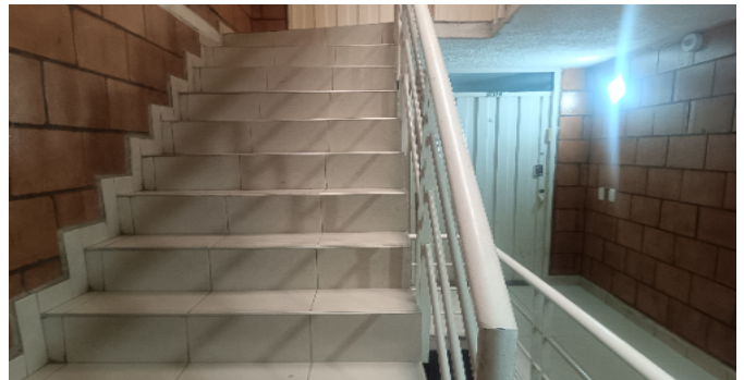
Escalera común - CJ
