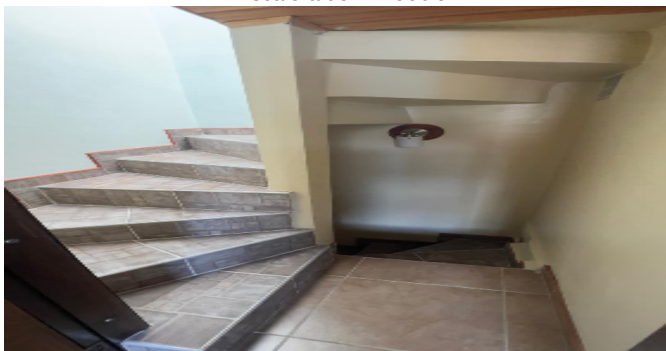
Escalera del inmueble
