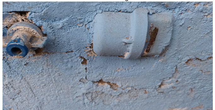
Contador de Agua
