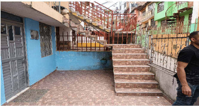
Escalera común - CJ
