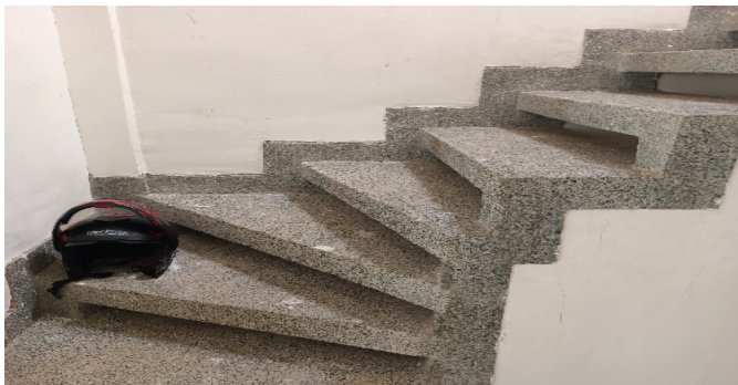
Escalera del inmueble
