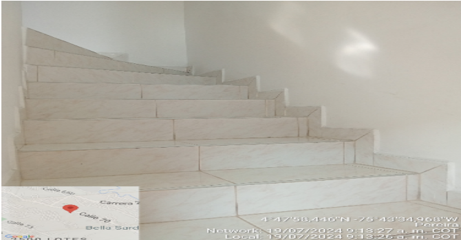
Escalera del inmueble
