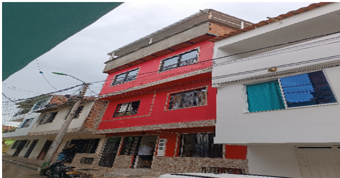
Fachada del Inmueble
