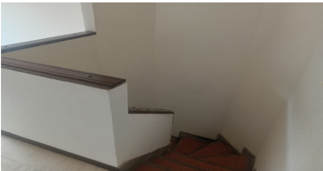
Escalera del inmueble
