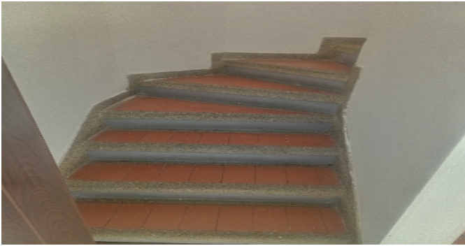
Escalera del inmueble
