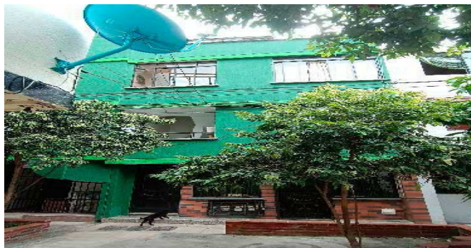
Fachada del Inmueble
