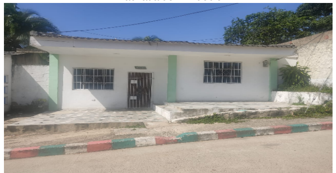
Fachada del Inmueble
