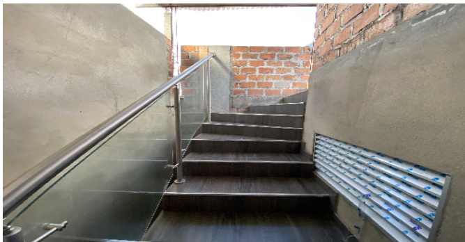
Escalera del inmueble
