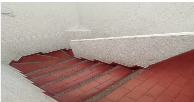
Escalera común - CJ
