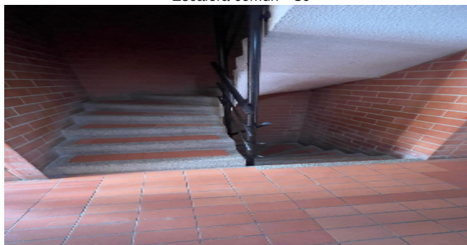
Escalera común - CJ
