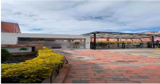
Fachada del Conjunto
