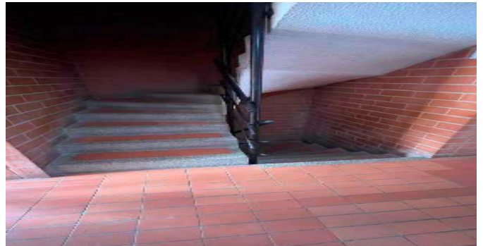
Escalera común - CJ
