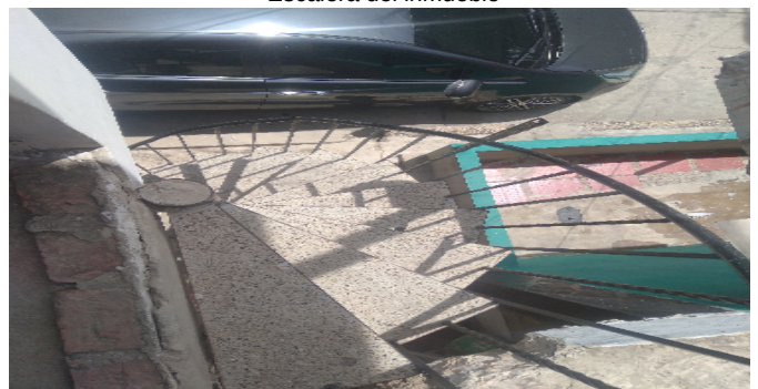
Escalera del inmueble
