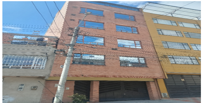
Fachada del Inmueble
