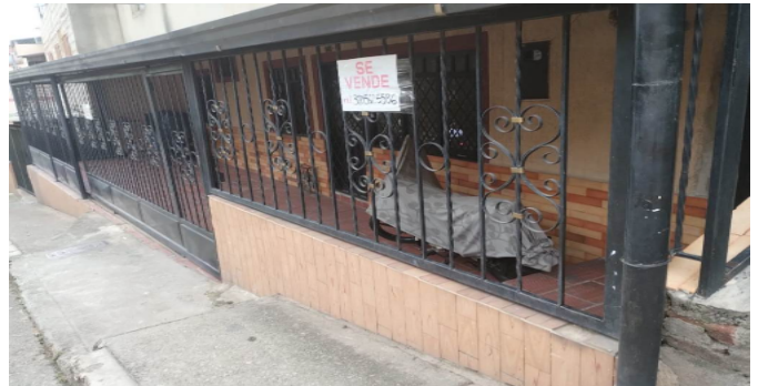
Fachada del Inmueble
