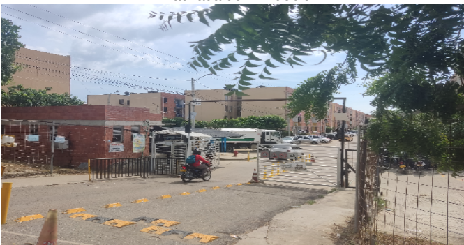
Fachada del Inmueble
